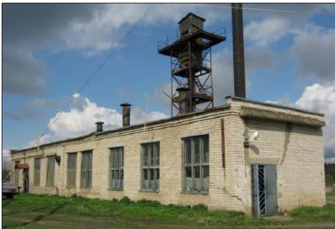
Рис. 1.2.1. Здание котельной д. Кузьмищи
